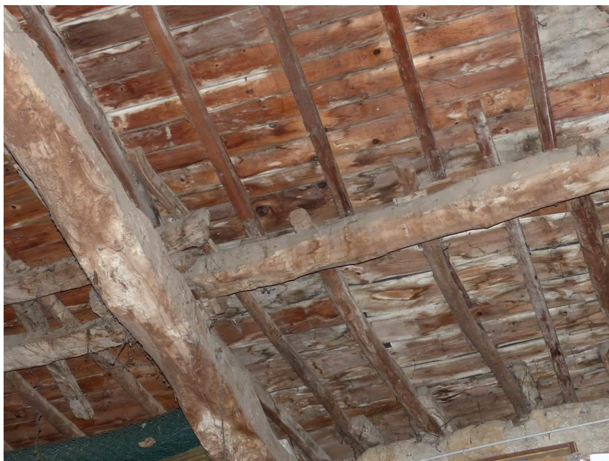
Charpente séculaire, en bois brut de peuplier noir (Beynost)
