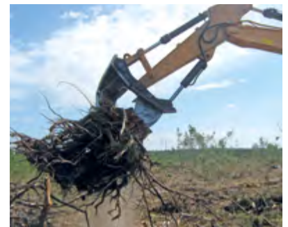
Figure 10 : Pelle équipée d'un outil d'extraction de souches © M. Monmousseau
